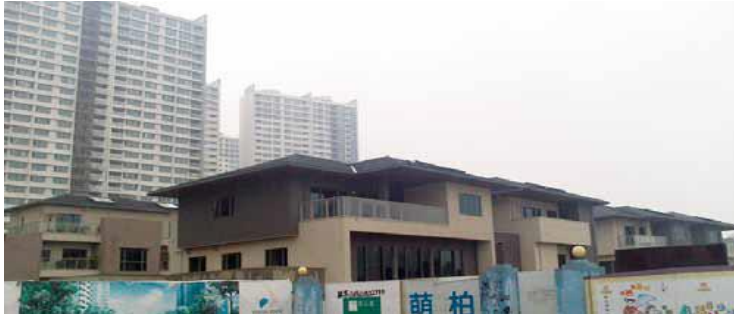
(写真1) 日系ハウスメーカーが建設中の戸建住宅
