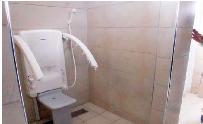
(写真2) 日系介護施設のシャワー設備
