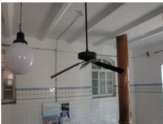
【以前、日本人が経営していた頃、ビール工場の天井に扇風機を設置。】
