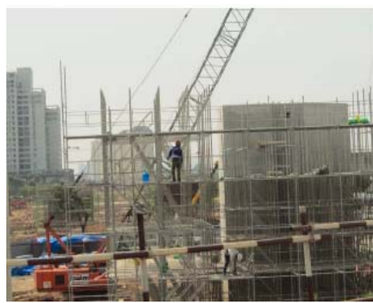
【写真：橋建設現場の風景】
