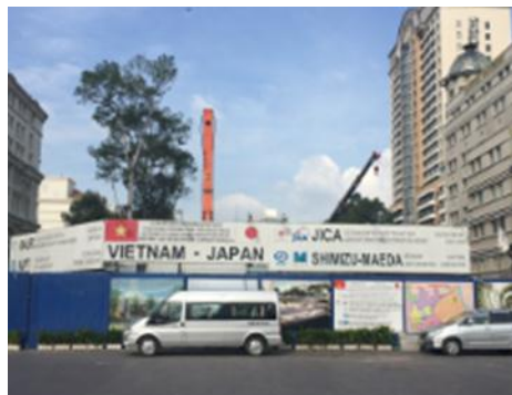
【地下鉄工事の様子】
